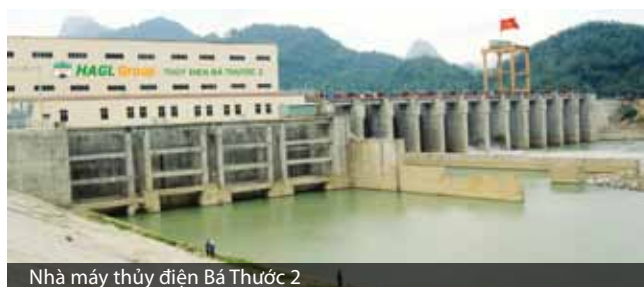
Nhà máy thủy điện Bá Thước 2
