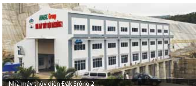
Nhà máy thủy điện Đắc Sùng 2
