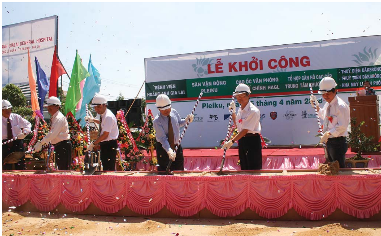
Lễ khởi công xây dựng bệnh viện, sân vận động, cao ốc văn phòng & căn hộ cao cấp - Tp Pleiku, Gia Lai
